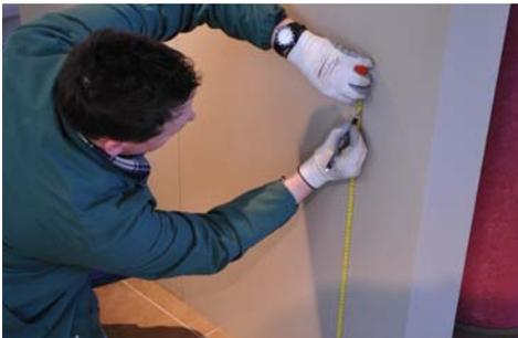
Nachdem Sie alle erforderlichen Maße ermittelt haben, markieren Sie an der Wand die Punkte für das Bohren und das Einsetzen der Dübel.
