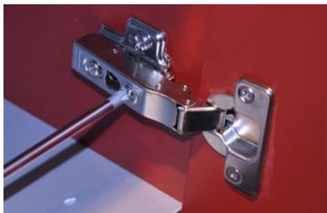
HORIZONTAL: Justierung durch die Schraube rechts außen.
