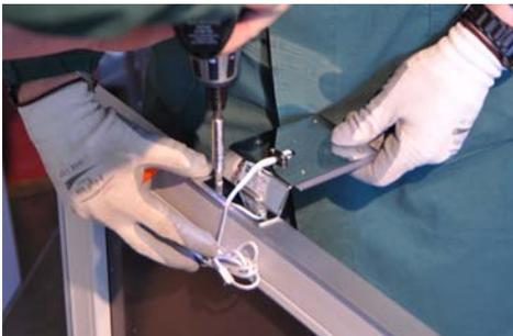
Bevor Sie den Spiegel endgültig an der Wand montieren, montieren Sie mit den mitgelieferten Schrauben zuerst die eventuell ausgesuchte Leuchte und schaffen Sie die elektrischen Verbindungen.
