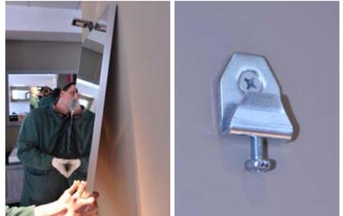
Befestigen Sie die Rahmenhaken an der Wand. Eine Feinjustierung kann durch Drehen der unteren Schraube erfolgen.
