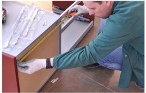
Die Befestigungswinkel werden auf der Innenseite der Seitenwände vorgesehen, achten Sie daher auf eine exakte Festlegung der Höhe und der Seitenabstände.
