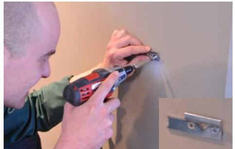
Nachdem Sie die Dübel in die Bohrungen gesetzt haben, montieren Sie die Befestigungswinkel. Achten Sie darauf, dass die Kupplung in Richtung Rückwand des Möbels zeigt.
