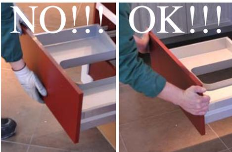
Für die weitere Montage entfernen Sie vorübergehend alle Schubladen.
