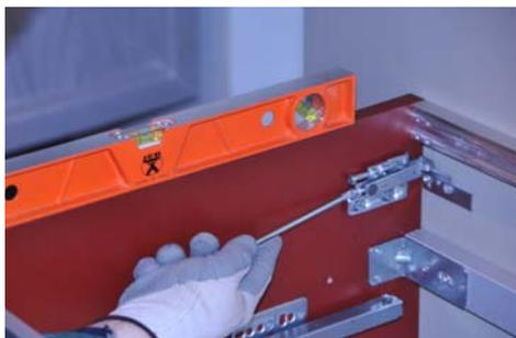
Die vertikale Justierung des Möbels erfolgt durch Drehen an der unteren Schraube.
