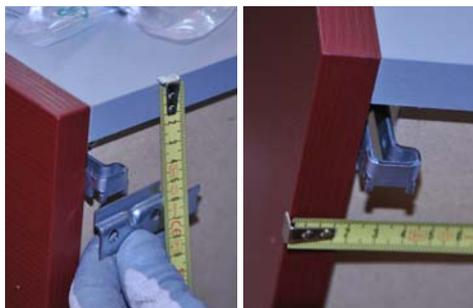
Achten Sie bei der Positionierung der Befestigungswinkel auf die Höhe und Seitenabstände des jeweiligen Schrankes.
