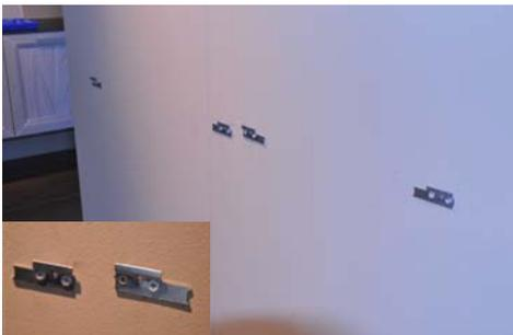
Nachdem Sie die Befestigungswinkel befestigt und nochmals alle Abmessungen geprüft haben, können Sie mit der Wandmontage des Möbels fortfahren.
