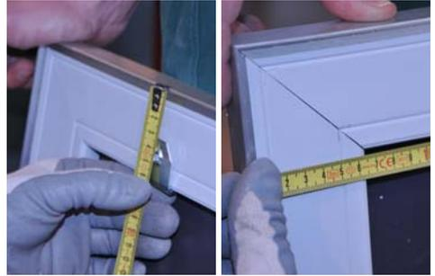
Notieren Sie die Rahmenabmessungen, um die Bohrlöcher an der Wand korrekt zu markieren.
