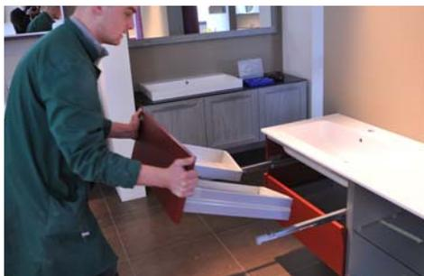
Nachdem Sie das Möbel an der Wand montiert haben, können die Schubladen wieder eingesetzt werden. Ziehen Sie dazu alle Führungsschienen heraus, positionieren Sie die Schublade auf den Schienen und schließen Sie die Schublade.
