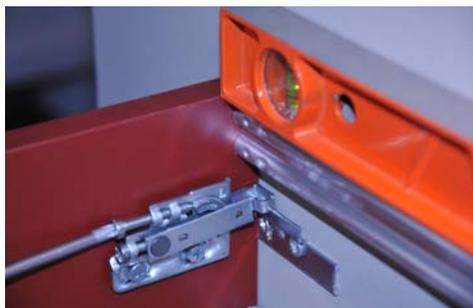
Die horizontale Justierung des Möbels erfolgt durch Drehen an der oberen Schraube.
