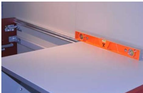
Nachdem Sie die sichere Verriegelung des Möbels mit dem Befestigungswinkel geprüft haben, prüfen Sie mittels Wasserwaage die horizontale Ausrichtung.
