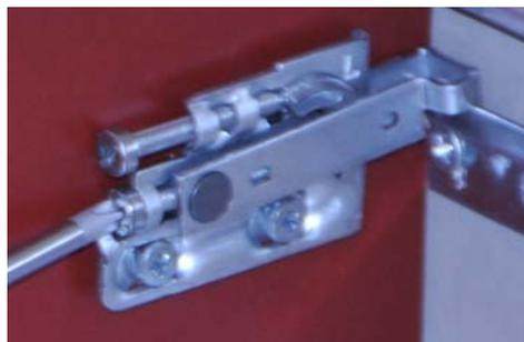
Die Tiefenjustierung + vertikale Ausrichtung des Möbels erfolgt durch Drehen der unteren Schraube des Befestigungsscharniers (siehe Abbildung).
