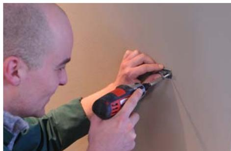
Markieren Sie an der Wand die Punkte der Bohrung, setzen Sie die Dübel in die angebrachten Bohrlöcher ein und montieren Sie die Befestigungswinkel.
