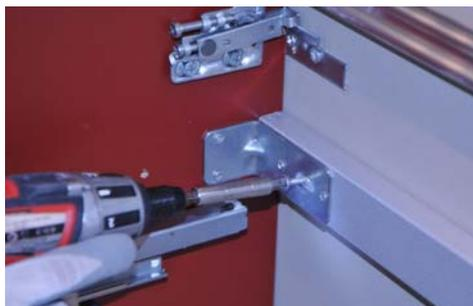
Danach nehmen Sie mit den mitgelieferten Schrauben und Dübeln die sichere Befestigung des Möbels am rückwärtigen Querträger des Möbels vor.
